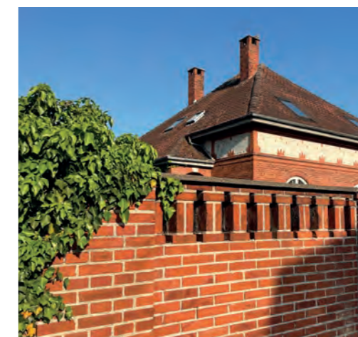
Gennemgåede røde teglsten Færgevej 3
